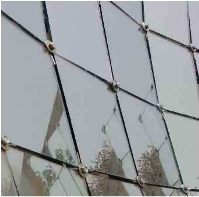
Particolare fissaggio specchi
